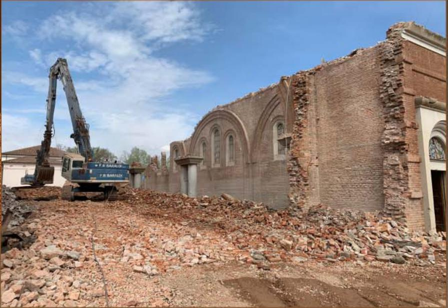
La demolizione continua sugli elementi di copertura e parte delle murature di parte del Presbiterio e dell'Abside.
