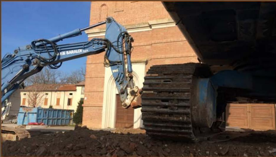
Attività di demolizione delle strutture di facciata con pinza idraulica su braccio telescopico articolato, dotata di denti e cesoia (1) e dotata di ganascia a dentatura e raggera variabile per la scomposizione dei detriti (2).
