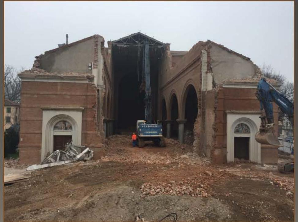
La demolizione continua sugli elementi di copertura e parte delle murature dei Transetti e di parte del Presbiterio.
